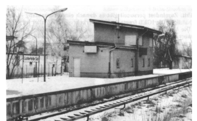
S-Bf Lichterfelde Süd: Hier werden vielleicht nie wieder S-Bahn-Züge fahren. Auch Herr Kammholz (F.D.P.) befürwortet die Pläne einer U-Bahn-Verlängerung auf der S-Bahn-Trasse von
