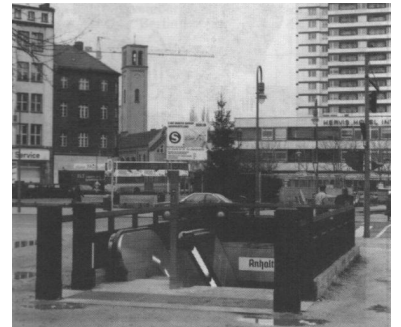
So nicht! Vor Beginn der Renovierung des S-Bf. Anhalter Bahnhof (Foto oben, 1985) gab es an allen drei Treppen einen unübersehbaren Hinweis auf die S-Bahn. Heute hilft nur noch das Bauschild zu erkennen, daß die Treppen wohl nicht zu einer Bedürfnisanstalt oder in eine Tiefgarage, sondern zur S-Bahn führen. (Foto: M. Lange)
