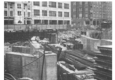
Blick aus der Mohren- zur Friedrichstraße. Südwestlich des U-Bahnhofs Stadtmittel in Berlin (Ost) wird z.Zt. ein Verbindungstunnel zwischen der in Richtung Pankow (Vinetastraße) fahrenden Ost-Berliner Kleinprofilstrecke und der in Richtung Alt-Mariendor fahrenden West-Berliner Großprofilstrecke (U6) gebaut.
