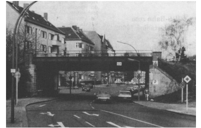
S-Bahn über die Nauener Straße zwischen Spandau-West und Staaken. Der Senat plant den Abbruch, um eine ausreichende Durchfahrtsmöglichkeit für den Umzug der Firma Orenstein un Koppel zu schaffen. Im SIGNAL 4/89 war auf S. 16 versehentlich eine falsche Karte abgebildet. (Foto: H.-P. Schwarz)
