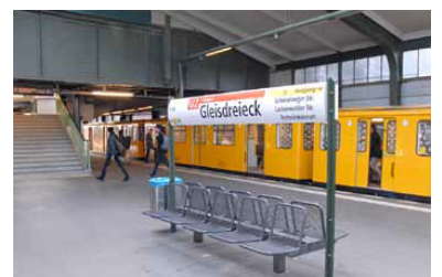
Bahnsteig der U 2 im U-Bahnhof Gleisdreieck. 2013 werden die jahrelangen umfangreichen Sanierungsarbeiten an dieser Station ausgesetzt, aber 2014 soll es weitergehen. (Foto: Marc Heller)
