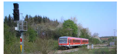
Bahnhof Ratzeburg an der Strecke Lüneburg--Büchen--Lübeck. Im Rahmen der Realisierung der festen Fehmarnbelt-Querung können durch Elektrifizierung dieser Strecke Umwegfahrten über den hochbelasteten Bahnknoten Hamburg vermieden werden. (Foto: Christian Schultz)
