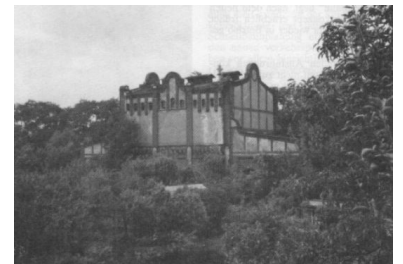
Blick von der Lützenstraße auf das ehemalige Pumpenhaus. Jahrzehntelanger Verfall hat seine Spuren hinterlassen. (Foto: U. Dittfurt)
