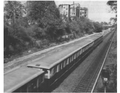
Wannseebahn, Blick von der Julius-Leber-Brücke in Fahrtrichtung Anhalter Bahnhof. Hier ist der S-Bf. Kolonnenstraße geplant, inzwischen nur noch mit einem Bahnsteig statt mit zweien. Dennoch verlegte die Senatsbauverwaltung den neuen Kabelkanal (links im Bild) weit neben die Gleise und ließ dafür hunderte von Bäumen, Sträuchern und Stauden beseitigen. Ist das der ökologische Stadumbau, den SPD und AL versprochen haben? (Foto: T. Billik)
