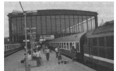
Abb. 1: Bahnhof Zoo, Bahnsteig A des in den letzten Jahren renovierten größten West-Berliner Personenbahnhofes im Sommer 1989.
