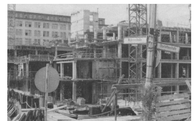
Berlin (Ost) im Sommer 1989: Lange wurde über den Bau einer Verbindung zwischen der Ost-Berliner U-Bahn-Linie A und der U6 für eine direkte betriebliche Verknüpfung spekuliert. Dieser Blick in die Baugrube an der hierfür wahrscheinlichsten Stelle belegt, daß derartige Pläne offenbar nicht bestehen bzw. gerade verbaut werden. (Foto: IGEB-Archiv)
