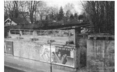
Abgebaute Brücken über die Leonorenstraße am S-Bf. Lankwitz. Bis 1994 wollen die Senatsplaner die Lankwitzer warten lassen, bis hier wieder S-Bahnen fahren. (Foto: REMA)
