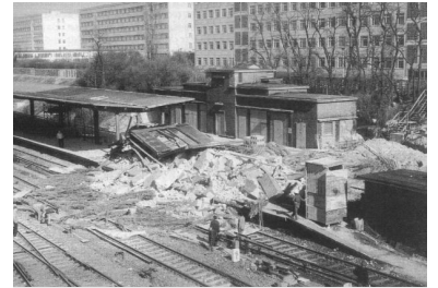
Gesprengt: S-Bf. Leninallee am 17.3.1990, 11.00 Uhr. Um ein direktes Umsteigen zu den Straßenbahn-Linien auf der Leninallee zu ermöglichen, sollen die Bahnsteige unter der Straßenbrücke hindurch verlängert werden. Deshalb mußte das alte Empfangsgebäude aus den späten 60er Jahren weichen. (Foto: U. Alexander)
