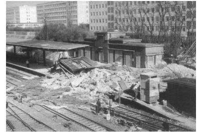
Gesprengt: S-Bf. Leninalle am 17.3.1990, 11.00 Uhr. Um ein direktes Umsteigen zu den Straßenbahn-Linien auf der Leninallee zu ermöglichen, sollen die Bahnsteige unter der Straßenbrücke hindurch verlängert werden. Deshalb mußte das alte Empfangsgebäude aus den späten 60er Jahren weichen. (Foto: U. Alexander)
