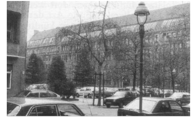
Parkplatz des Rathauses Charlottenburg. Nach Änderung der Berliner Bauordnung brauchen für öffentliche Gebäude, wenn sie gut von der BVG erschlossen werden, keine Stellplätze mehr nachgewiesen zu werden. Damit wird wertvolles innerstädtisches Bauland gewonnen. Auch dieser Parkplatz soll dann bebaut werden, da das Rathaus direkt am U-Bf. Richard-Wagner-Platz steht. (Foto: Ch. Tschepe)
