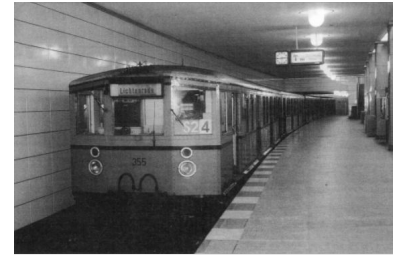
S-Bf. Anhalter Bahnhof. Seit dem 2. Mai enden hier die Züge der S2. Dafür fahren die bisher im Anhalter Bf. endenden Wannseebahn-Züge (S1) bis Frohnau. (Foto: T. Staeck)
