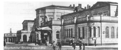
Am Bf. Potsdam Stadt, dem früheren Hauptbahnhof, halten seit dem 15. Juli wieder D-Züge. Doch das repräsentive Empfangsgebäude steht leider nicht mehr, während das S-Bahn-Gebäude (links im Bild) gut erhalten ist. (Foto: DR)
