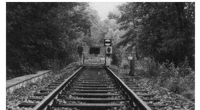
Prellbock vor der Teltowkanalbrücke. Von Wannsee bis Kohlhasenbrück ist ein S-Bahn-Gleis nach Potsdam schon wieder aufgebaut, daß derzeit aber nur als Prüfgleis genutzt wird. (Foto: Ch. Tschepe)
