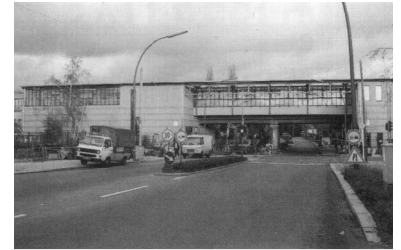
Am 1. Dezember wurde der S-Bahnhof Schichauweg eröffnet. Der Bahnhof liegt über der Straße mit Zugängen von beiden Seiten, so daß ein bequemes Umsteigen zum Bus 30 möglich sein wird. (Foto: M. Heller)
