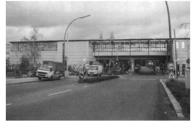
Am 1. Dezember wurde der S-Bahnhof Schichauweg eröffnet. Der Bahnhof liegt über der Straße mit Zugängen von beiden Seiten, so daß ein bequemes Umsteigen zum Bus 30 möglich sein wird. (Foto: M. Heller)
