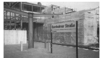
Schon lange vor Abschluß der Arbeiten wurde der S-Bahnhof wiedereröffnet. Der eingerüstete Abgang führt auf den geplanten Bahnsteig B, an dem später einmal alle Züge nach Norden abfahren werden. (Foto: U. Dittfurth)
