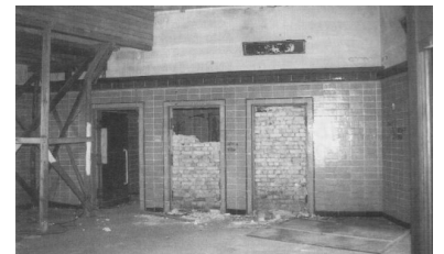
Das Empfangsgebäude des S-Bahnhofs Bornholmer Straße zu Beginn der Bauarbeiten im Sommer 1990. (Foto: M. Heller)
