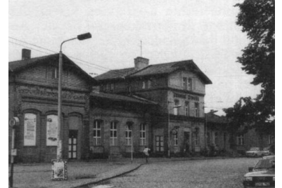
Die Nahverkehrszüge zwischen Belzig (Foto oben) und Drewitz (Foto unten) sollen zur besseren Übersichtlichkeit des Angebotes im Berliner Umgang als R-Bahn bezeichnet und mit einer Liniennummer versehen werden. (Foto: G. Radke)
