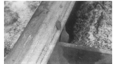
Die Münze verdeutlicht den ausgefästen Schienenkopf im Abschnitt Grätzwalde - Jägerstraße, der in den Sommermonaten erneuert werden soll. (Foto: I. Köhler)
