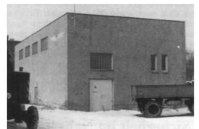
Betriebsbereit: Das neue Unterwerk auf dem Betriebsgelände der Straßenbahn in Schöneiche. (Foto: I. Köhler)
