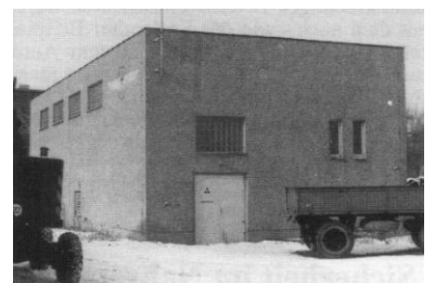
Betriebsbereit: Das neue Unterwerk auf dem Betriebsgelände der Straßenbahn in Schöneiche. (Foto: I. Köhler)
