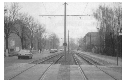
Linie 22 nach Rosenthal. Die Strecke erfüllt schon heute wichtige Anforderungen eines modernen Straßenbahnbetriebes. So gibt es zum Beispiel lange Abschnitte mit eigener Trasse. Begegnungsmöglichkeiten (Bild oben) erlauben einen attraktiven Betrieb trotz überwiegend eingleisiger Strecke, und bei Bedarf kann sofort mit dem zweigleisigen Ausbau begonnen werden (Bild unten) (Foto: M. Horth)
