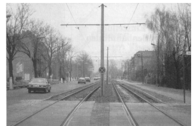
Linie 22 nach Rosenthal. Die Strecke erfüllt schon heute wichtige Anforderungen eines modernen Straßenbahnbetriebes. So gibt es zum Beispiel lange Abschnitte mit eigener Trasse. Begegnungsmöglichkeiten (Bild oben) erlauben einen attraktiven Betrieb trotz überwiegend eingleisiger Strecke, und bei Bedarf kann sofort mit dem zweigleisigen Ausbau begonnen werden (Bild unten) (Foto: M. Horth)
