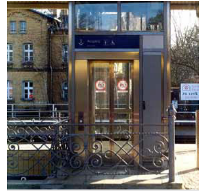
Aufzug auf dem Fern- und Regionalbahnsteig in Berlin-Wannsee. Ab 11. Dezember 2011 endeten die Regionalzüge aus Brandenburg für ein Jahr in Berlin-Wannsee. Die Fahrgäste mussten den Regionalbahnsteig verlassen und auf die S 7 umsteigen. Doch der neue Aufzug wurde erst im April 2012 fertig. (Foto: Marc Heller)
