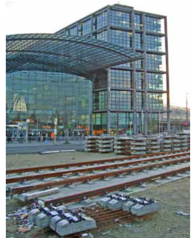
Vor dem Hauptbahnhof liegen zwar schon Gleise, aber die Inbetriebnahme der Straßenbahn wurde inzwischen auf 2014 verschoben. Möglicherweise wird es sogar erst 2015. Hauptursache sollen unerwartete Probleme der Berliner Wasserbetriebe mit den unter der Invalidenstraße vorgefundenen Kanälen sein. (Foto: Florian Müller)
