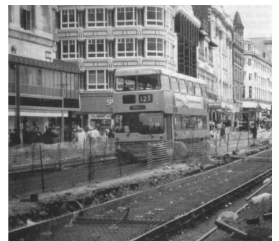
In der Innenstadt von Manchester laufen die Bauarbeiten für die neue Stadtbahn auf Hochtouren, damit der Eröffnungstermin für den ersten Bauabschnitt zum Ende dieses Jahres eingehalten werden kann. (Foto: M. Horth)
