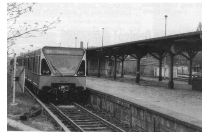
S-Bahn-Zug im Bf. Tegel (April 1991). Seit Sommer 1990 finden regelmäßig Fahrten auf dem intakten Gleis zwischen Schönholz und Tegel statt, leider noch ohne Fahrgäste. (Foto: B. Strowitzki)
