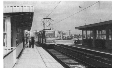
Die Straßenbahn-Neubaustrecke am U-Bf. Hellersdorf. Die Anlage ermöglicht kurze Umsteigewege, aber die Fahrplanabstimmung zwischen Tram und U-Bahn ist noch unbefriedigend. (Foto: I. Köhler)
