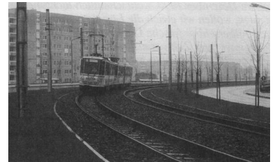
Das Bild zeigt den im Neubaugebiet geradezu verschwenderischen Umgang mit der Fläche. Immerhin wurde der üppige Straßenquerschnitt nicht nur zur Anlage breiter Fahrbahnen, sondern auch zur Anlage von Grünstreifen neben der Straßenbahntrasse genutzt. Noch besser wäre es aber gewesen, wenn auch die Trasse selbst eingegrünt worden wäre. Sogenannte Rasengleise sind in vielen Städten inzwischen selbstverständlich. (Foto: I. Köhler)
