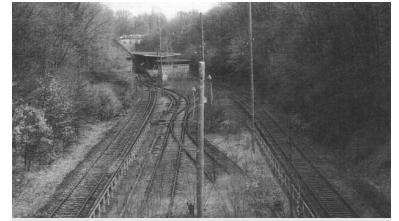
S-Bf. Pichelsberg an der Spandauer Vorortbahn, stillgelegt seit 1980. Solange hier nicht wieder S-Bahn-Züge fahren, wodurch die Regionalzüge aus dem Osthavelland in Spandau enden könnten, behindern sich die Regional- und Fernverkehrszüge auf den eingleisigen Abschnitten zwischen Spandau und Berlin Hbf gegenseitig. Das Resultat: beide Angebote können nicht mit attraktiven Takten gefahren werden. (Foto: M. Heller)
