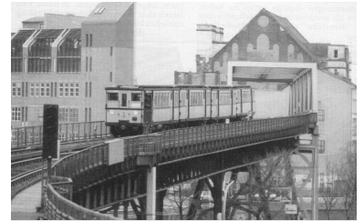
Am 18. Februar wurde die Berliner U-Bahn 90 Jahre alt. Eröffnet wurde der Betrieb damals mit der Strecke Stralauer Tor - Potsdamer Platz. Anlässlich des Jubiläums ließ die BVG am Sonnabend, dem 15.2. den A1-Museums-Zug zwischen Gleisdreieck und Kottbusser Tor fahren. Das Foto zeigt den Zug auf der Fahrt zum Bf. Möckernbrücke. Hinter dem Zug sind rechts die 1990 erneuerte Brücke über den Landwehrkanal und links der BVG-Neubau an der Trebbiner Str. mit Rechenzentrum und Stellwerk zu sehen. (Foto: Th. Billik)
