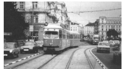
Währinger Straße in Wien. So einfach und preiswert ist es, das Gleis der Tram freizuhalten. Im Notfall können die Schwellen von den Autos überfahren werden. Solche oder ähnliche Lösungen findet man in vielen Städten - ausgenommen Berlin. (Foto: M. Horth)
