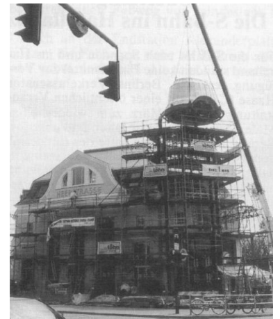
S-Bf. Heerstraße. Seit dem 14. Mai hat das Bahnhofsgebäude wieder seine markante Kuppel. Jetzt fehlt nur noch der S-Bahn-Betrieb. (Foto: E. Kuntzscg)
