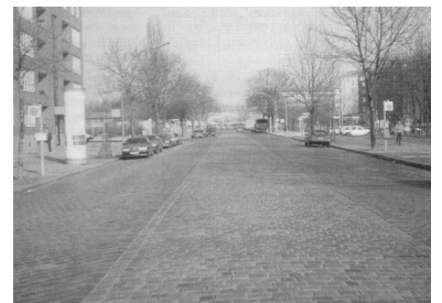
Im Straßenpflaster der Bernauer Straße ist die ehemalige Straßenbahntrasse noch gut zu erkennen. Aber jetzt hat sie hier keinen Platz mehr, meint der Verkehrssenator, weil hier der innerstädtische Auring geplant ist. Stattdessen soll die Tram nach rechts auf den ehemaligen Grenzstreifen verbannt werden, der aber bereits für das Mauer-Museum, Wohnungsbau und Grünflächen verplant ist. (Foto: Matthias Horth)
