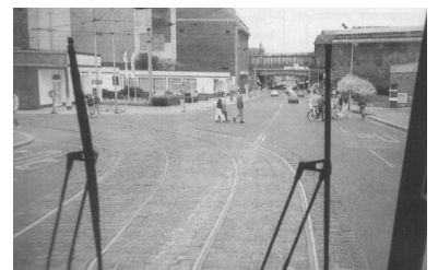
Noch bis zuletzt wollte Verkehrssenator Haase die Tram aus der Friedrichstraße verbannen. Jetzt ist er per Senatsbeschluß verpflichtet worden, den Lückenschluß bis zur Leipziger Straße zeitgleich mit den Bahnsteigumbauten auf der U6 zu realisieren. (Foto: Frank Brunner)
