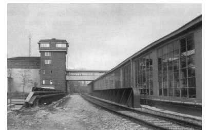
Fernbahngleis am S-Bf. Westkreuz (Ringbahnhalles). Hier könnte ein Seitenbahnsteig für einen Fernbahnhof Berlin Messe gebaut werden, an dem IC-, IR- und Regionalbahn-Züge halten. (Foto: Georg Radke)
