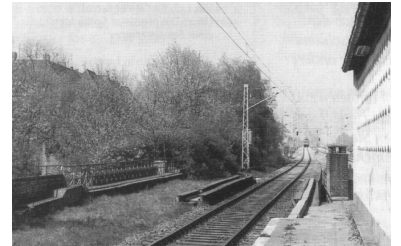
Bf. Baumschulenweg, Blick nach Norden im Bild ist die Trasse des ehemaligen Fernbahngleis nach Neukölln zu sehen. Hier sollen nach den Vorstellungen des Konzeptes Berlin 94 bald wieder Züge fahren, darunter der IC zwischen Hamburg und Dresden (Linie 7). (Foto: Georg Radke)
