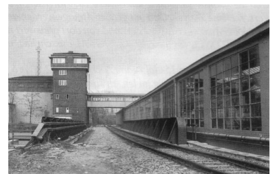
Fernbahngleis am S-Bf. Westkreuz (Ringbahnhalle). Hier könnte ein Seitenbahnsteig für einen Fernbahnhof Berlin Messe gebaut werden, an dem IC-, IR- und Regionalbahn-Züge halten. (Foto: Georg Radke)
