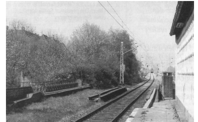
Bf. Baumschulenweg, Blick nach Norden im Bild ist die Trasse des ehemaligen Fernbahngleis nach Neukölln zu sehen. Hier sollen nach den Vorstellungen des Konzeptes Berlin 94 bald wieder Züge fahren, darunter der IC zwischen Hamburg und Dresden (Linie 7). (Foto: Georg Radke)
