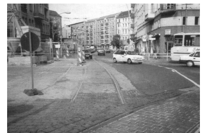
Herbst 1993: Unterbrochene Tramgleise auf der Friedrichstraße. Wo einst eine Geradeausfahrt durch die Friedrichstraße möglich war, steht jetzt ein Baukran. Doch dieser Kran ist noch nicht das letzte Hindernis. 1994/95 werden bisher verschwiegene Sanierungsarbeiten am U6-Tunnel die Tram aus der Friedrichstraße fernhalten. (Foto: I. Schmidt)
