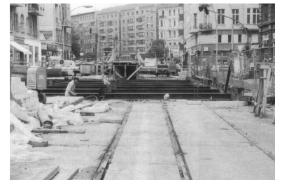
Herbst 1992: Unterbrochene Tram-Gleise auf der Friedrichstraße. Wegen der Sanierung der Weidendammer Brücke und wegen der Bauarbeiten zur Verlängerung des U-Bahnhofs Oranienburger Tor (siehe Foto) ist der Straßenbahnverkehr auf der Friedrichstraße seit Juli 1992 eingestellt. (Foto: Thomas Billik)
