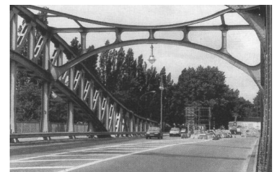
Auch bei der Erneuerung der Fahrbahndecke auf der Brücke wurde keine Vorleistungen erbracht. Anstatt Gleise zu verlegen, wurde die künftige Tram-Trasse lediglich abmarkiert. (Foto: Matthias Horth)
