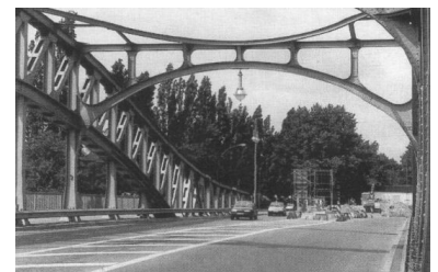
Auch bei der Erneuerung der Fahrbahndecke auf der Brücke wurde keine Vorleistungen erbracht. Anstatt Gleise zu verlegen, wurde die künftige Tram-Trasse lediglich abmarkiert. (Foto: Matthias Horth)
