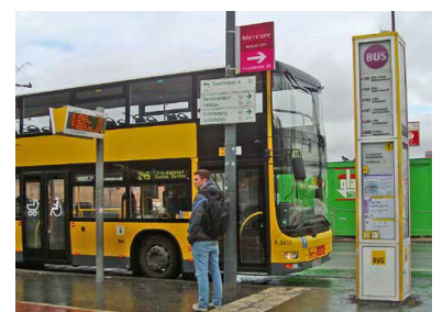
Um die Funktionalität an der Haltestellensäule aufzufinden, ist schon etwas Spürsinn gefordert. Unten an der Stele die Taster, in der Mitte der Lautsprecher, links der Daisyanzeiger, dessen Text vorgelesen wird. (Foto: Florian Müller)
