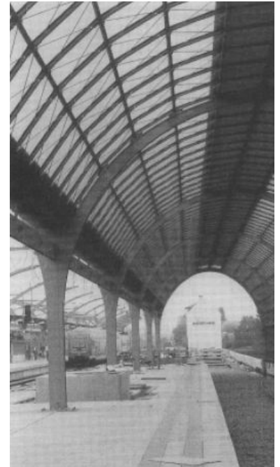
Bf Spandau: S-Bahnsteig Richtung Falkensee. (Foto: Heinz-Peter Schwarz, Mai 1998)
