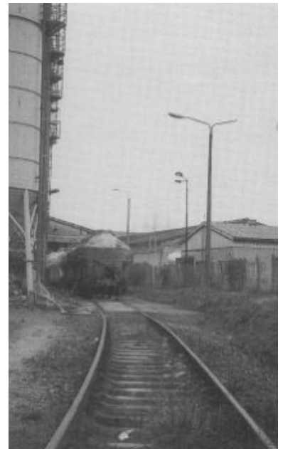
Gleisanschluß in Luckau. Rückgrat der NLE ist zur Zeit noch der Güterverkehr. (Foto: Stephan Müller, Dezember 1994)
