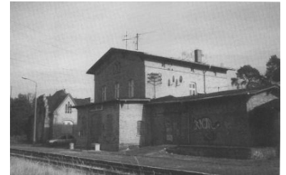
Bf Zehdenick-Neuhof: auch hier sind erste Vandalismusspuren sichtbar. (Foto: S. Müller)
