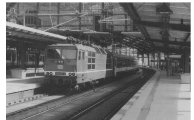
Bahnhof Berlin-Friedrichstraße: auch für bestimmte Züge des Fernverkehrs wären dort ausreichend lange Bahnsteigkanten vorhanden. (Foto: Christian Schultz)
