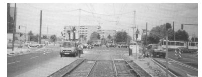
Von der BVG vorfinanzierter Neubau der Ampelanlage Landsberger Allee/Allee der Kosmonauten (Foto: Frank Brunner)
