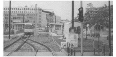
Bauen und Fahren am U-Bahnhof Hellersdorf. (Foto: Frank Brunner)
