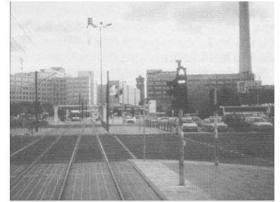
Straßenbahn-Ampel vor der Haltestelle Alexanderplatz: Die Fußgänger haben grün, die Straßenbahn muß warten. Auch hier ist der Aufenthalt der Straßenbahn nicht nötig. (Foto: Frank Brunner)
