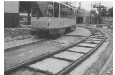
Straßenbahn-Dauerbaustelle Alexanderplatz im August 1999. (Foto: Marc Heller)
