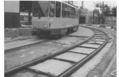
Straßenbahn-Dauerbaustelle Alexanderplatz im August 1999. (Foto: Marc Heller)
