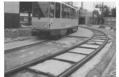
Straßenbahn-Dauerbaustelle Alexanderplatz im August 1999. (Foto: Marc Heller)
