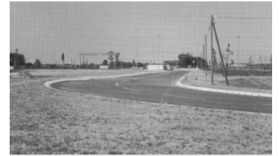
Umschlagbahnhof Großbeeren: werktags, am frühen Abend. Statt Hochbetrieb Sonntagsruhe. (Foto: Christian Schultz)
