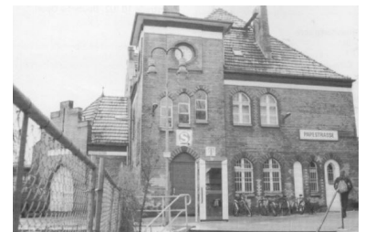
Empfangsgebäude des Bahnhofs Papestraße heute. (Foto: Marc Heller)
