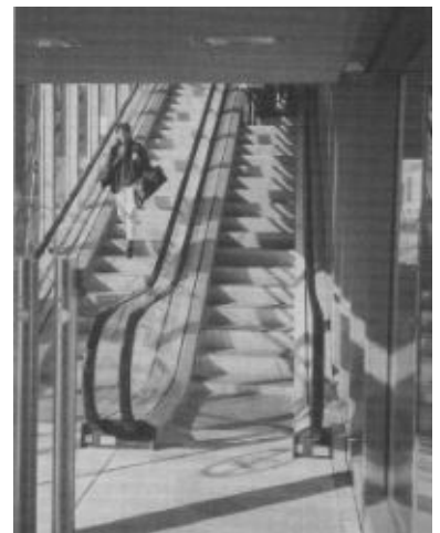
Als eine Fehlplanung werden sich nach Ansicht des Bahnkunden-Verbandes diese Rolltreppen erweisen. Ihre Kapazität ist zu gering. (Foto: Frank Böhnke)
