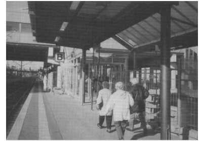
Pro Bahnsteig gibt es zwei solcher Treppenhäuser. Der hier im Bild gezeigte Glaskasten birgt je eine aufwärts- und eine abwärtsfahrende Rolltreppe. Die Festtreppe, nur 2,70 Meter breit, befindet sich auf der anderen Seite der Spange. (Foto: Frank Böhnke)
