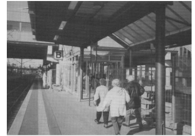
Pro Bahnsteig gibt es zwei solcher Treppenhäuser. Der hier im Bild gezeigte Glaskasten birgt je eine aufwärts- und eine abwärtsfahrende Rolltreppe. Die Festtreppe, nur 2,70 Meter breit, befindet sich auf der anderen Seite der Spange. (Foto: Frank Böhnke)
